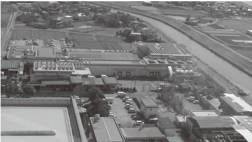
施設の外観：屋上には多数の太陽光発電パネルを設置
